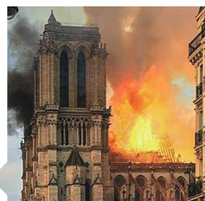
Un incendie extérieur mais aussi intérieur.
